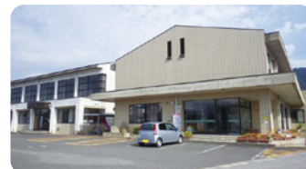
改修を予定している新横江公民館
