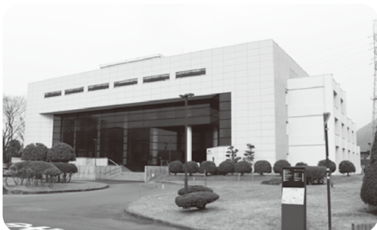
アウトフレーム工法による耐震工事が行われた文化センター
