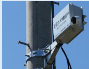
防犯カメラ設置
