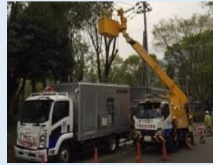
災害時の停電復旧作業
